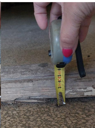
Fot. 6. Wysokość progu drzwi wewnętrznych.
