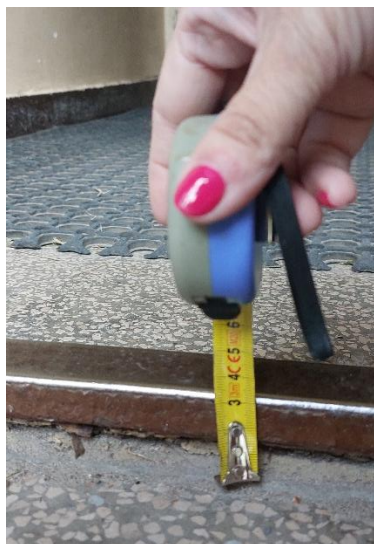
Fot. 5. Wysokość progu drzwi wejściowych.
